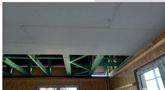
KROK 3 – Připevnění desek OSB Firestop
