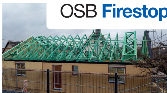
KROK 1 – Instalace střešních vazníků
