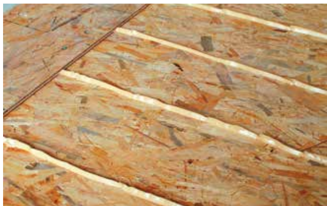
Obrázek 13 Lepení OSB desek pružným lepidlem pomocí pistole
